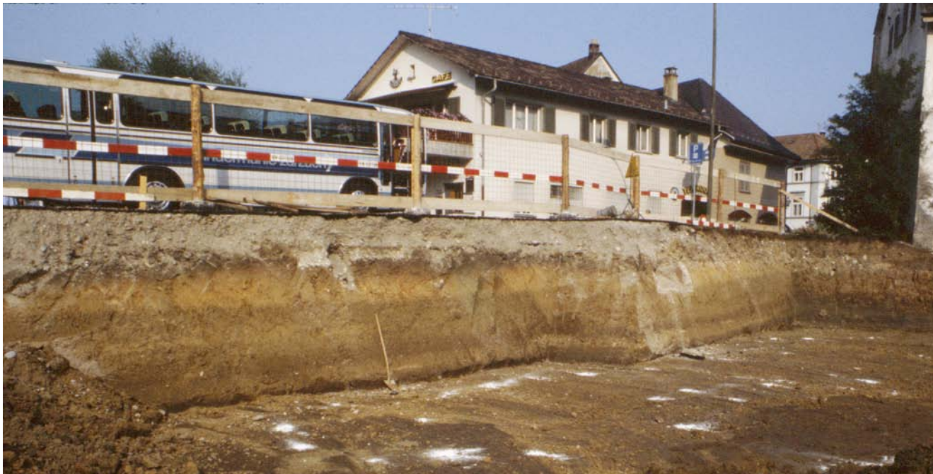
Links: Baugrube Höflibanbau Quellenstrasse 1, 1984. Deutlich zeichnet sich unter der einer dunklen humösen Schicht die helle gelbliche Schwemmschicht des 2./3. Jahrhunderts ab. Darunter liegen ältere Schwemmschichten.
