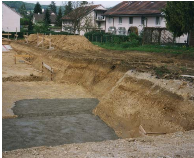
Baugrube Schulhaus Tiergarten 2001. Auch hier ist die gelbe Schwemmschicht auf die ganze Länge zu sehen. In der Ausbuchtung (Bildmitte) zeichnet sich darunter ein Graben ab, der wahrscheinlich von einem alten Bachlauf stammt (Detail unten). Ein vergleichbarer Graben war 1984 in der Baugrube Parkhotel zu sehen (Abb. nächste Seite)
