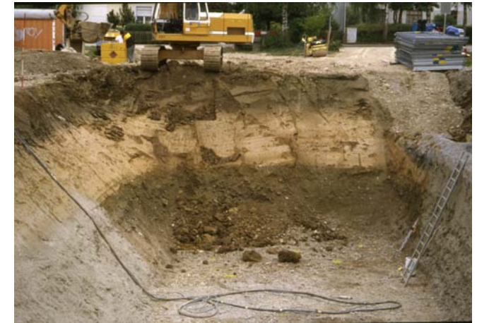
Oben: Baugrube für die Holzschnitzelanlage beim Gemeindesaal, 1999. Hier ist die gelbe Schwemmschicht bedeutend stärker als sonst. Unweit davon entfernt floss einst ein Arm des Zurzibachs vorbei. In der grünen Lehmschicht darunter liessen sich keinerlei Spuren menschlicher Einwirkung erkennen.
